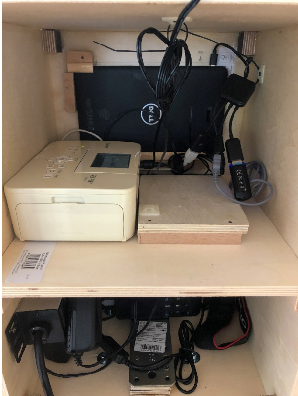
Ausgestattete Box mit Sockel für den Drucker. Rechts oben ist der Adapter für das Tablet zu erkennen, links unten die Steckdosenleiste.
